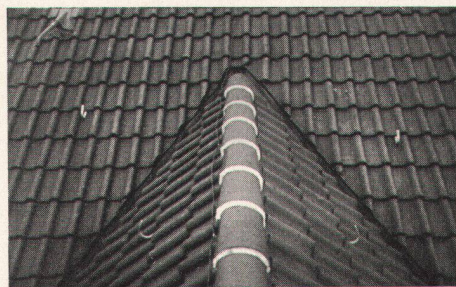
Dachdeckerarbeit: Ausschnitt aus einem Ziegeldach
