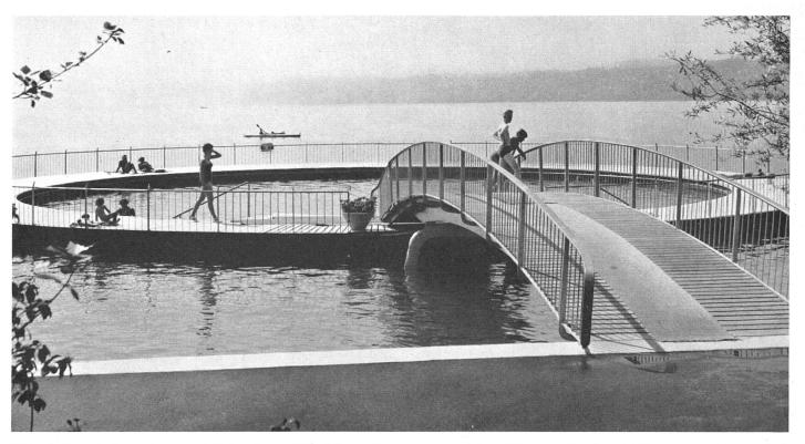
$Nichtschwimmerbecken;\ schwimmerde\ Caissonkonstruktion\ |\ Bassin\ des\ non-nageurs;\ caisson\ flottant\ en\ ciment\ arm\'e\ |\ Non-swimmers'\ basin;\ floating\ reinforced\ concrete\ construction$
