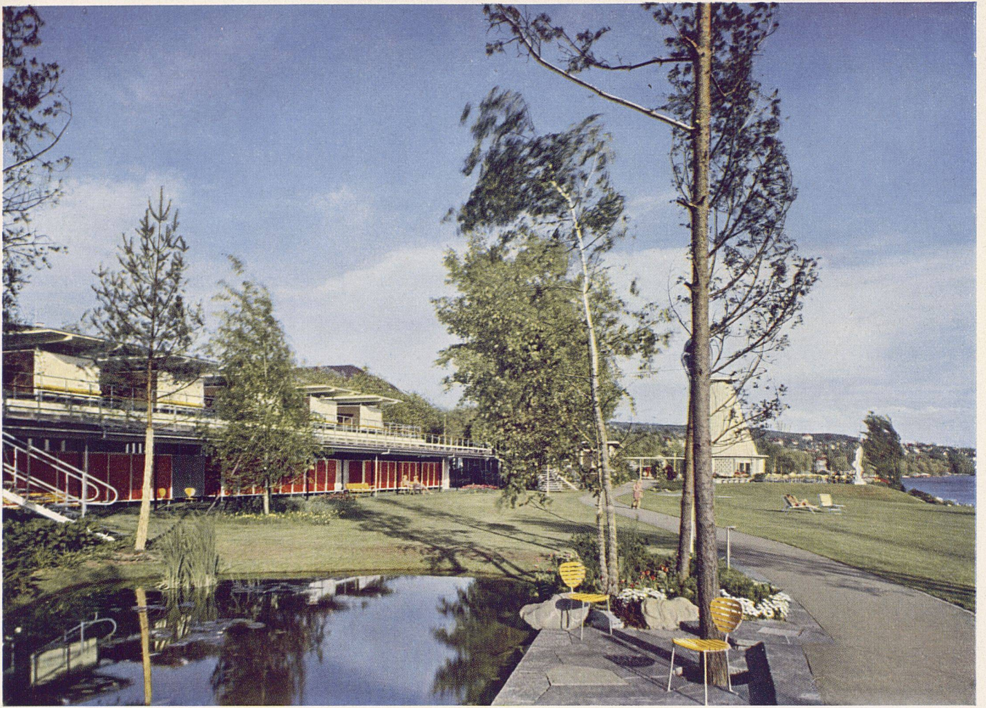
Männergarderoben mit Blick gegen Teerestaurant / A gauche, vestiaires hommes; au fond, pavillon-restaurant / Men's cloakrooms towards the tea pavilion Farbphoto: Walter Binder, Zürich
