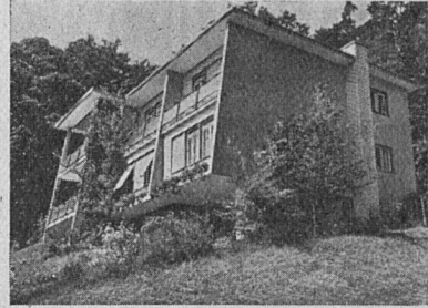
Wohnhaus in Olten. Architekt: Hermann Frey BSA/SIA, Olten
