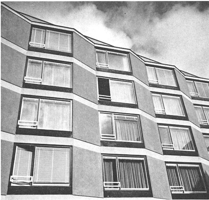
Ausschnitt Südwestfassade, vorfabrizierte Betonelemente / Façade sud-ouest, détail / Detail of south-west elevation
