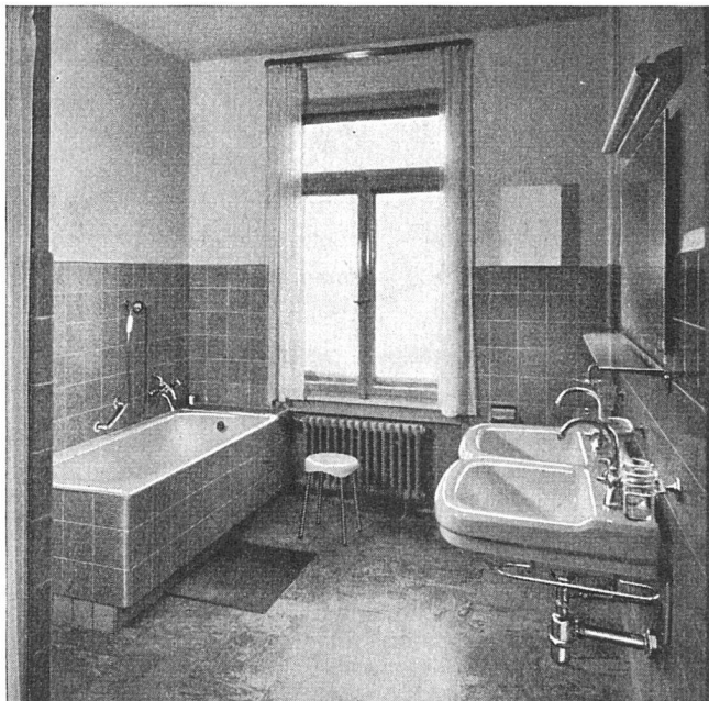
Aus unserer Ausstellung: Badezimmer mit Apparaten in Elfenbein
