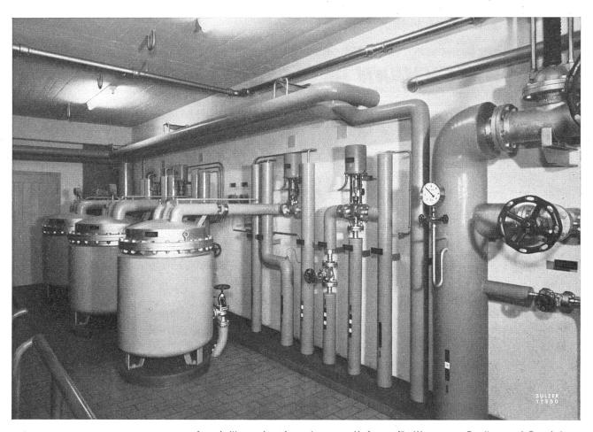
Ausschnitt aus dem Apparateraum - Umformer für Warmwasser-Bereitung und Raumheizung
