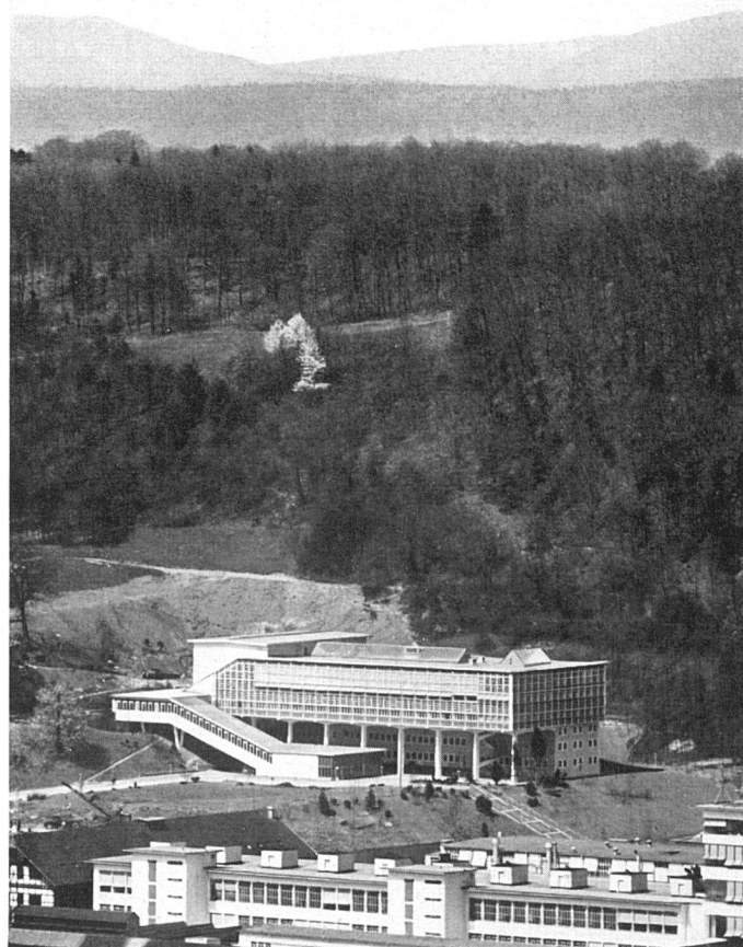
Gesamtansicht von Osten mit Fabrikbauten / Vue d'ensemble prise de l'est / General view from the east Photo: J. Schmidli, Baden
