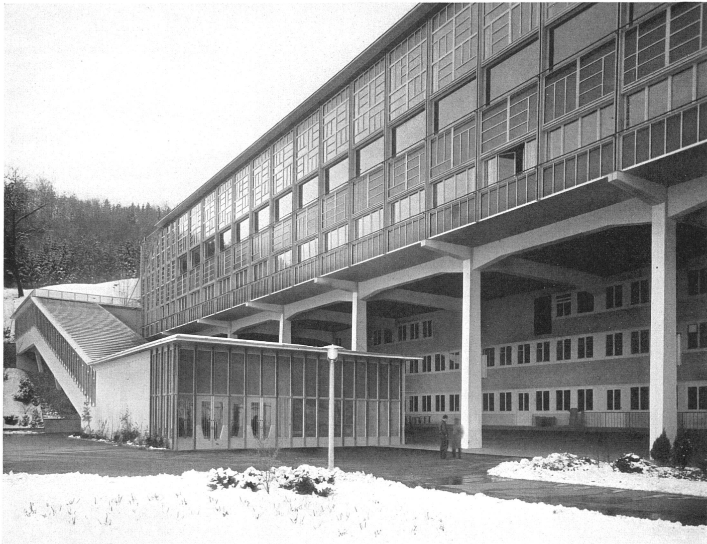
Südfassade, Treppeneingang und Wirtschaftshalle / Façade sud, entrée et escalier, hall de service / South elevation, entrance and staircase
