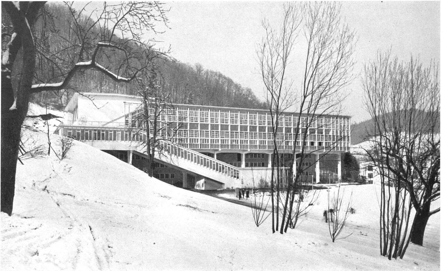
Gesamtansicht des Gemeinschaftshauses von Süden mit Zufahrtsstraße | Le foyer social ouvrier de la S. A. Brown, Boveri & Cie., à Baden. Vue d'ensemble prise du sud | Social centre of the Brown, Boveri machine factory at Baden. General view from the south
