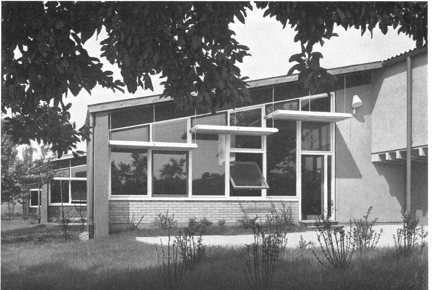
Sonderklasse von außen / Extérieur d'une salle de classe spéciale pour enfants arriérés / Exterior of a special classroom
