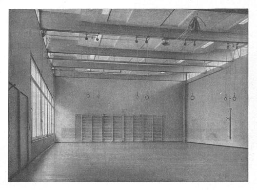
Ideal-Strahlheizkörper bestehen aus gußeisernen Heizregistern mit horizontalen und vertikalen Wasserwegen mit aufgeschraubter Strahlplatte. Diese können sichtbar oder unsichtbar angeordnet und in Anpassung an die gegebenen Raumverhältnisse an beliebiger Stelle eingebaut werden. Zur Erzielung der besten Heizwirkung installiert man sie vor-
