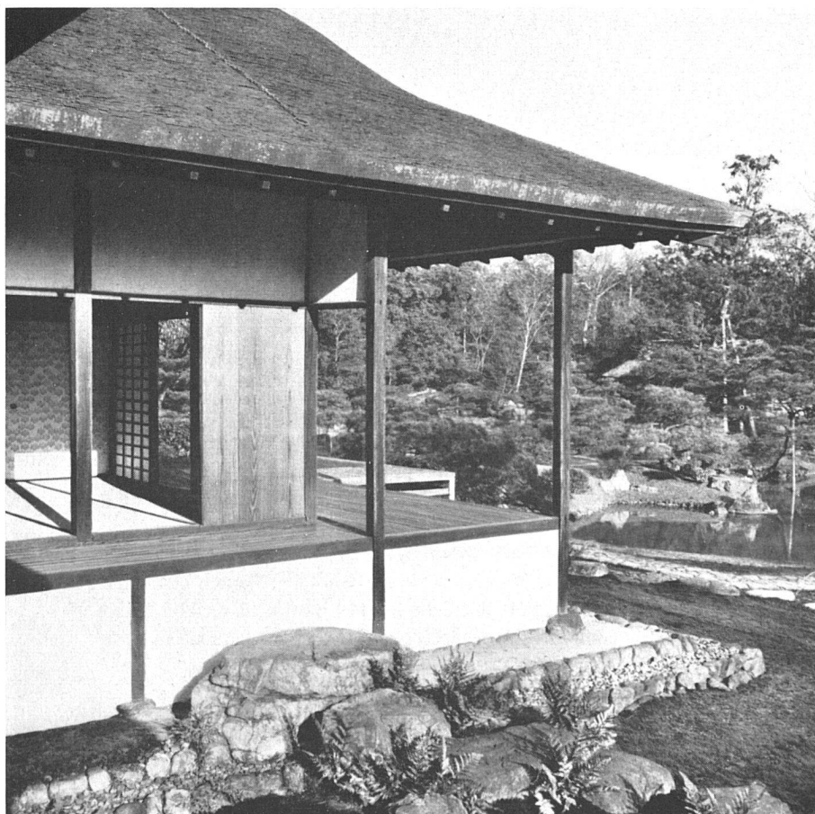
Katsura-Palast in Kyôto, 1602. Ein weit vorspringendes Dach bedeckt den Umgang. Das vom Dach tropfende Wasser wird von einem Bett von Kieselsteinen aufgefangen | Le palais Katsoura. L'eau du toit tombe dans une plate-bande de cailloux formant ornement autour de la maison | The Katsura Palace. The rain water of the roof is collected by a gravel bed
