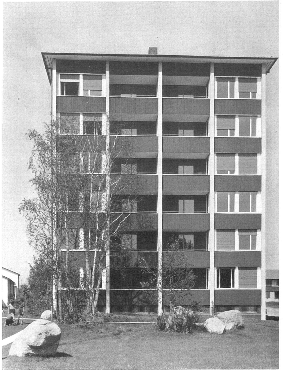
Südfassade des Turmhauses | Immeuble locatif, façade sud | South elevation of apartment block Photos: P. Grünert, vorm. H. P. Herdeg, Zürich
