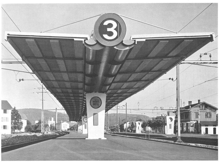
1 Stirnansicht des Bahnsteigdaches | Marquise de quai, en éléments préfabriqués, vue frontale | Side elevation of the platform shelter
