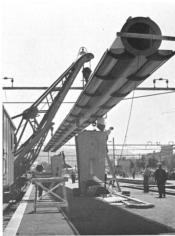
4 Montage des Hauptträgers, Teilstück von 54 m Länge / Montage de la poutre tubulaire; première partie longue de 54 m / Erection of the tubular beam, 1st part 54 m of length
