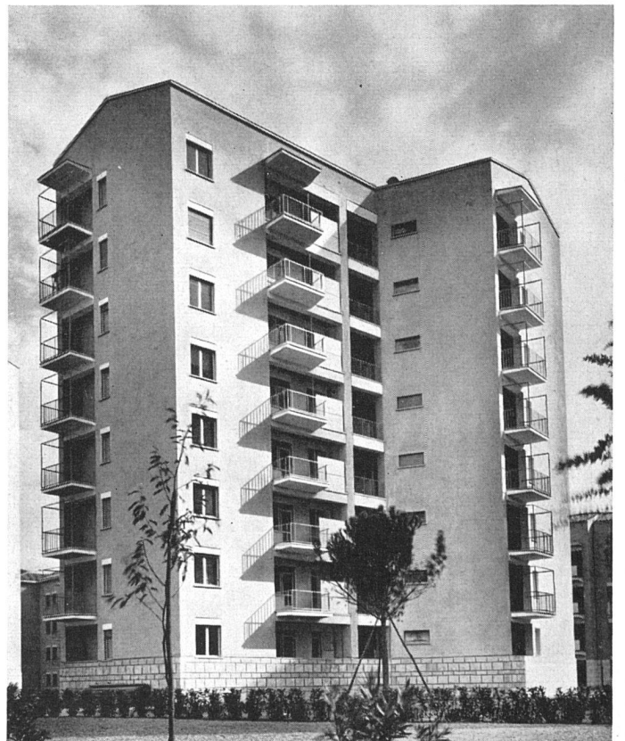
Ein Turmhaus. Architekten G. Pediconi und M. Paniconi / Un immeuble-tour / A point-house
