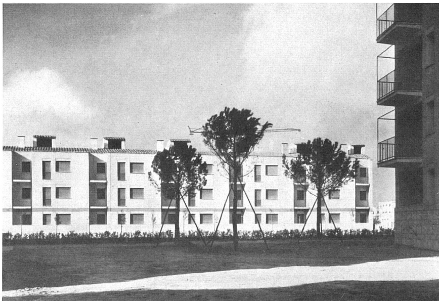
Wohnblock A von Süden | Immeuble A; vue prise du sud | Block of flats A, from the south
