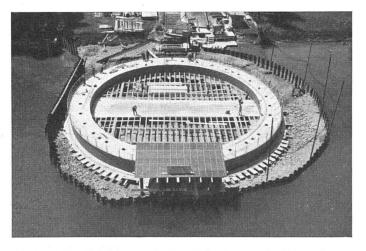
Schwimmendes Nichtschwimmerbecken  $\varnothing$  27 m in armiertem Beton, während der Bàuausführung im Trockendock
