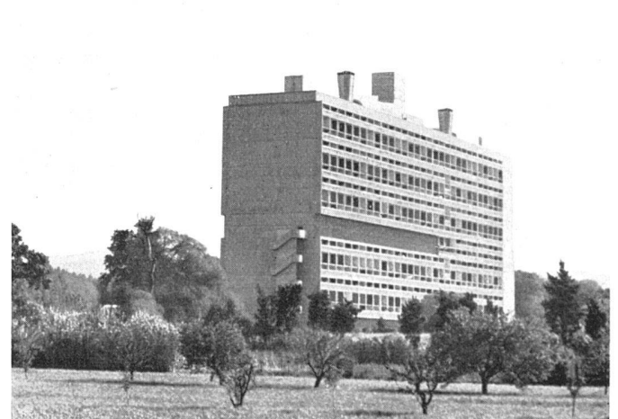
Aus Nordwesten / Vue prise du nord-ouest / From the north-west
