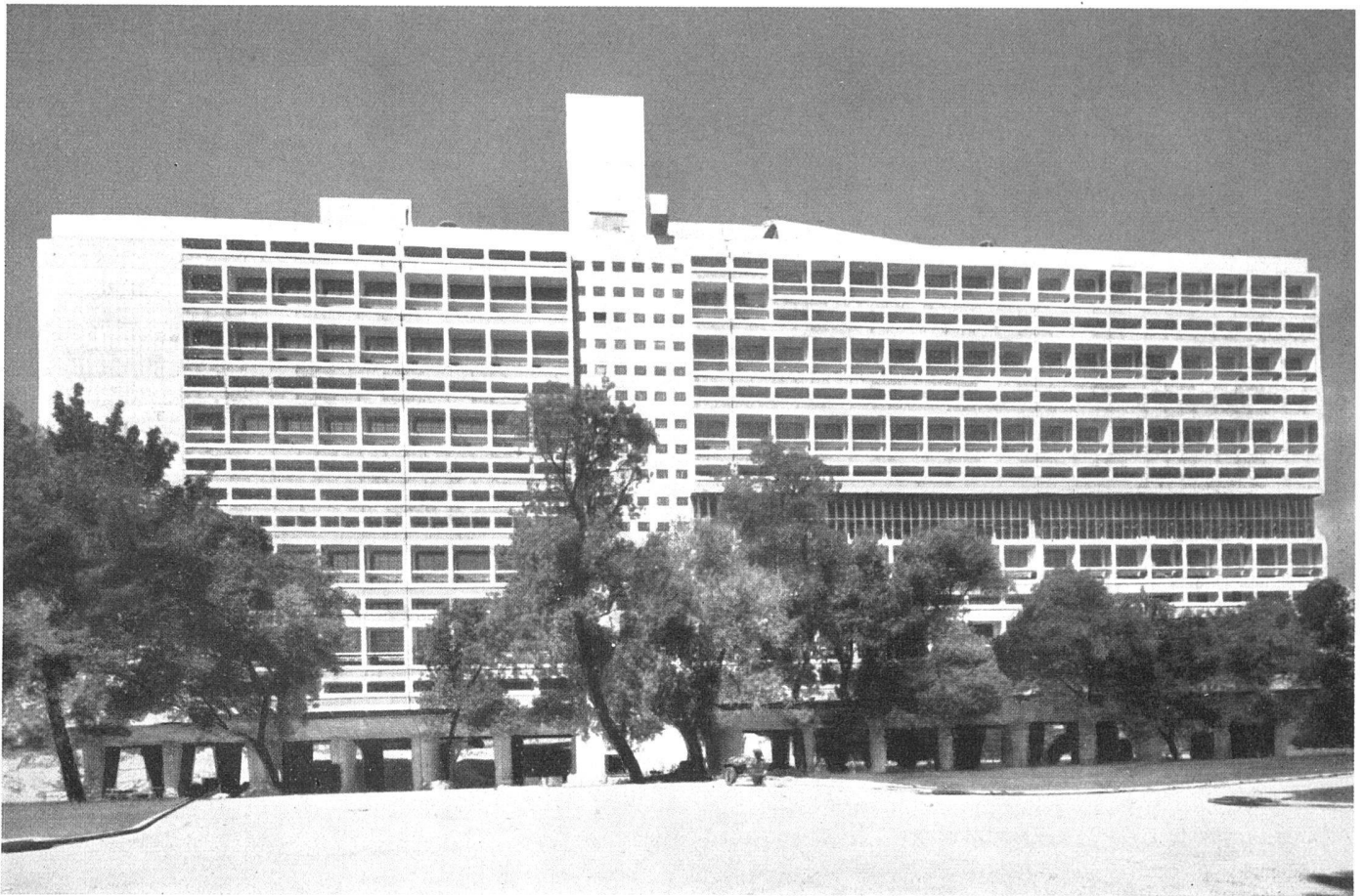
Gesamtansicht vom Boulevard Michelet (Ostseite) / Façade est / East elevation, from Boulevard Michelet
