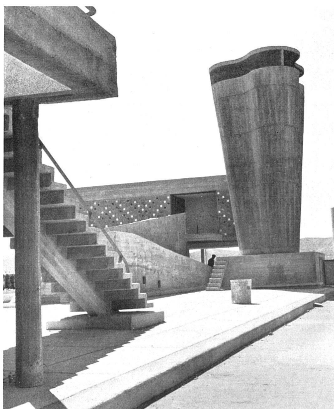
Dachterrasse, Ventilationskamin / Toit-terrasse, cheminée de ventilation; béton brut / Roof garden, all in rough concrete
