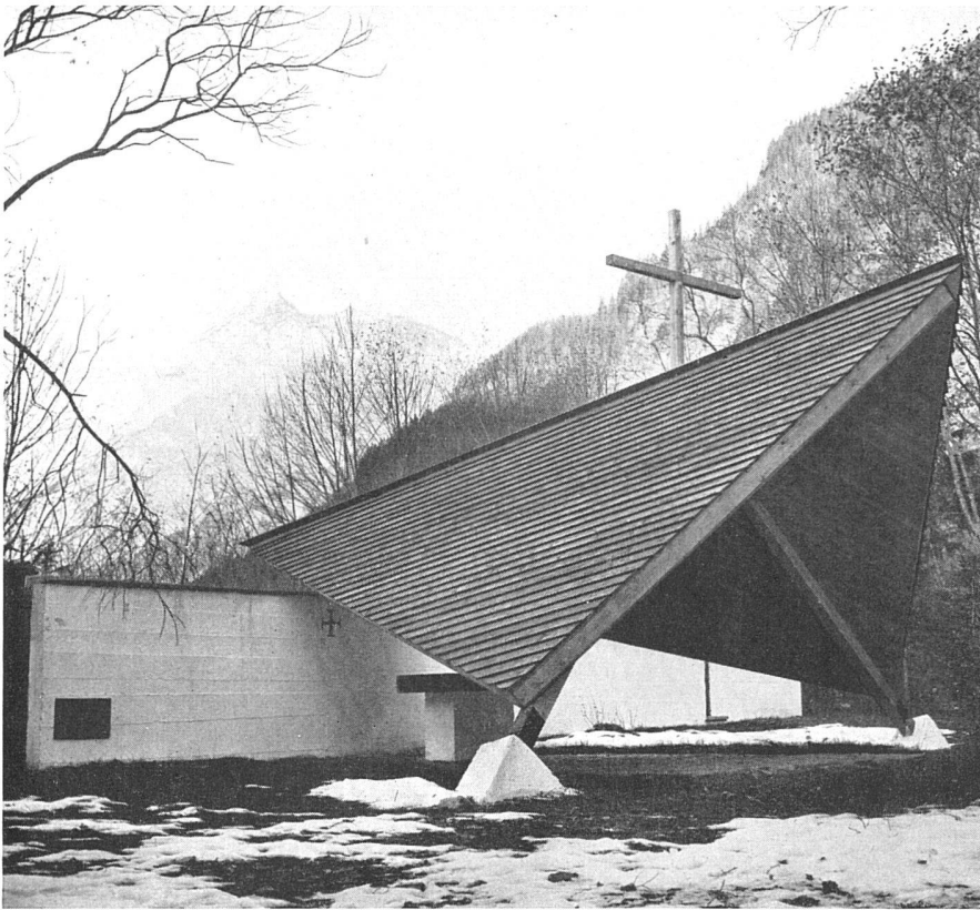
Ansicht von Westen / Vue prise de l'ouest / From the west
