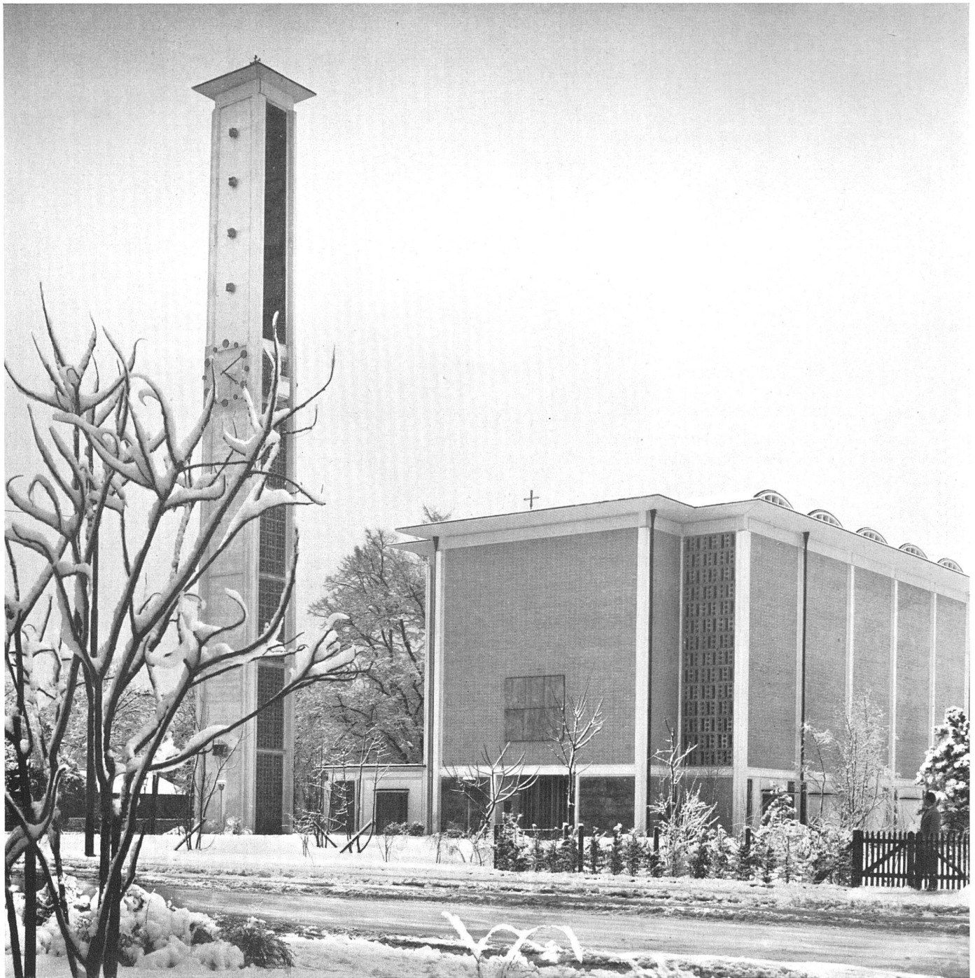
Gesamtansicht von Süden mit Eingangsfront / Clocher et façade principale, vue prise du sud / Bell-tower and entrance elevation, from the south
