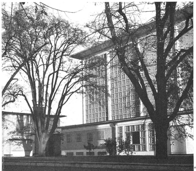
Blick von Westen auf Kirche und Pfarrhaus | L'église et le presbytère, vue prise de l'ouest | Church and parson's house, from the west
