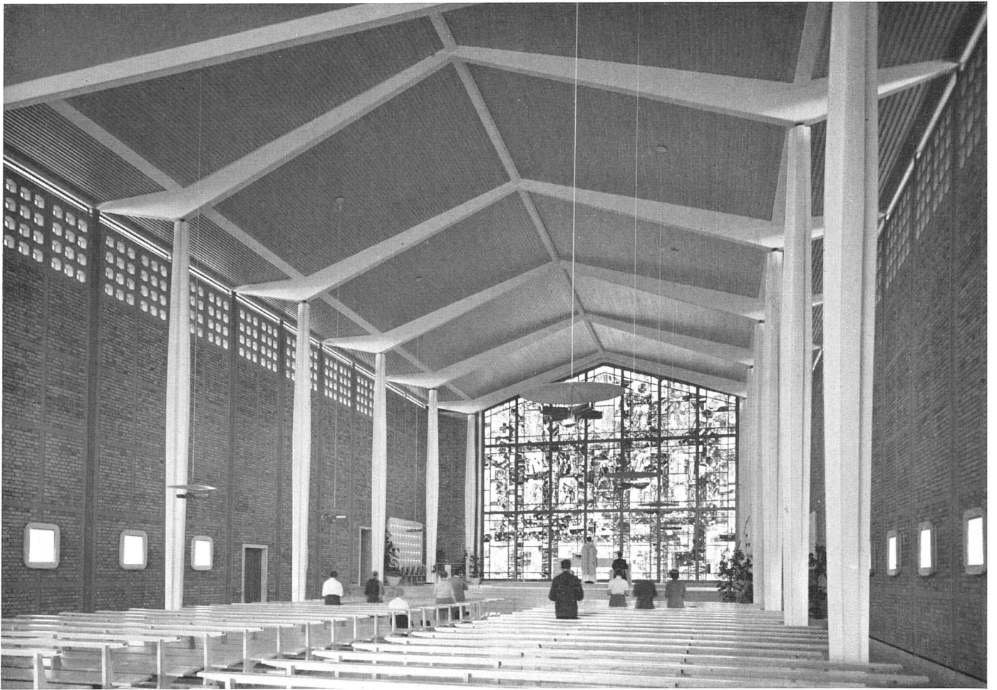
Der Kirchenraum. Eisenbeton weiß, Decke Holz natur, Wände Spezial-Backstein | Intérieur | Interior
