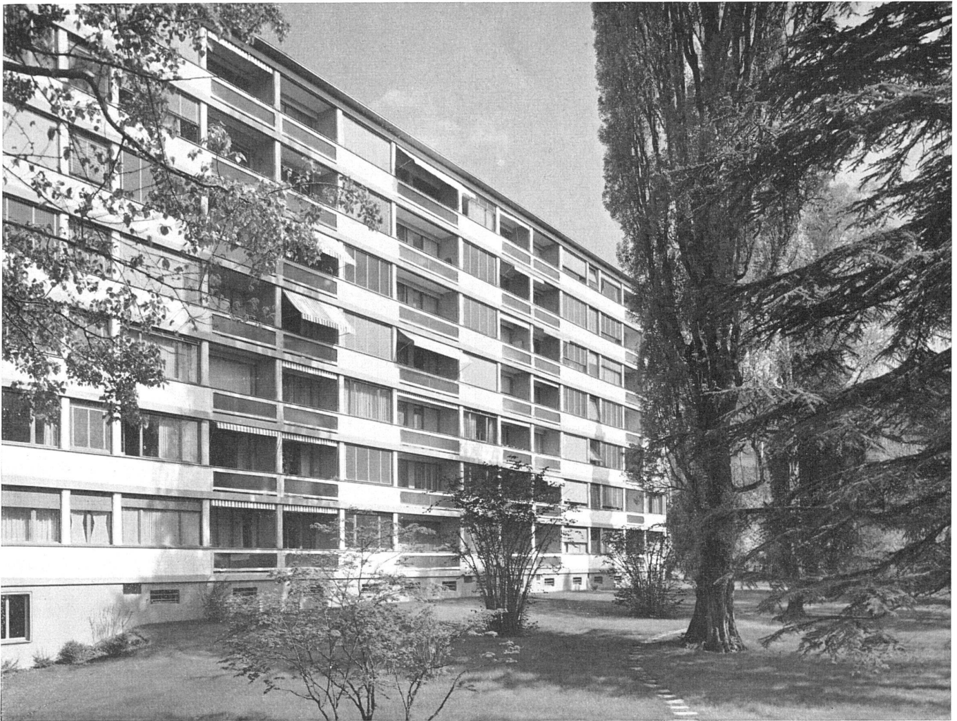
Vue prise du sud-ouest / Gesamtansicht von Südwesten / From the south-west
