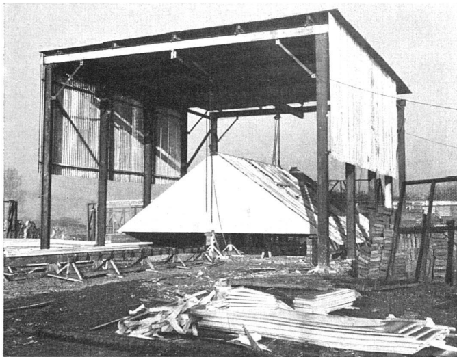
Fabrikation der Dachstühle in offener Halle / Fabrication du faitage / Manufacturing of roof elements
