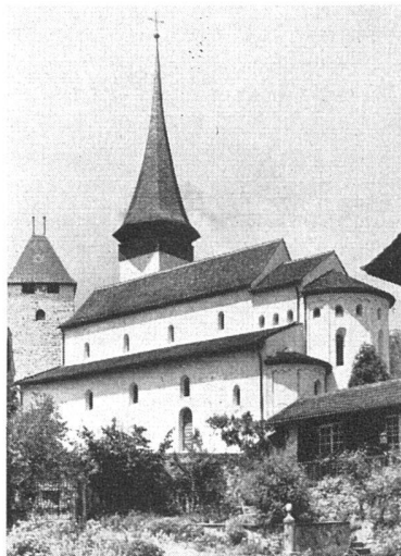
Schloßkirche Spiez. Ansicht von Südosten nach der Restaurierung
