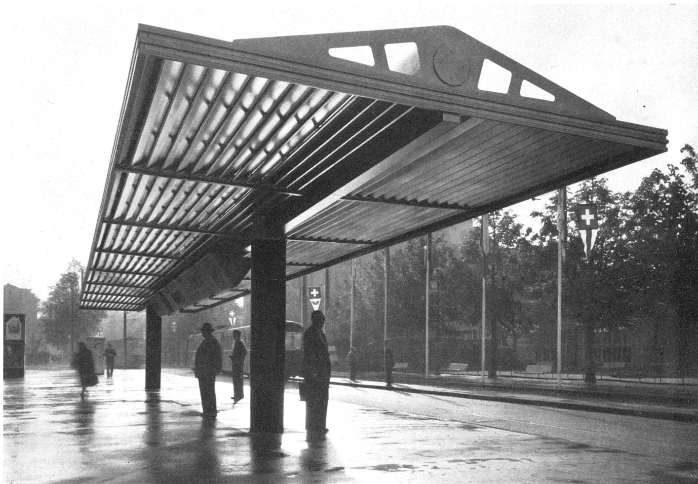
Das Perrondach vor dem Mustermessegebäude in Basel, System «Shadelite», ganz aus Aluminium, Säulen schwarz / Arrêt de tramway abrité à Bâle, système «Shadelite», exécuté entièrement en aluminium / Tramway station in Basle, system: «Shadelite», prefabricated aluminium construction Photo: Atelier Eidenbenz, Basel
