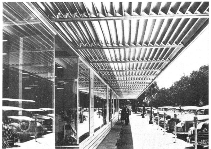
Shadelite-Vordach über einem Laden in USA / Avant-toit d'un magasin, système «Shadelite», Etats-Unis / Shadelite shop canopy in USA
