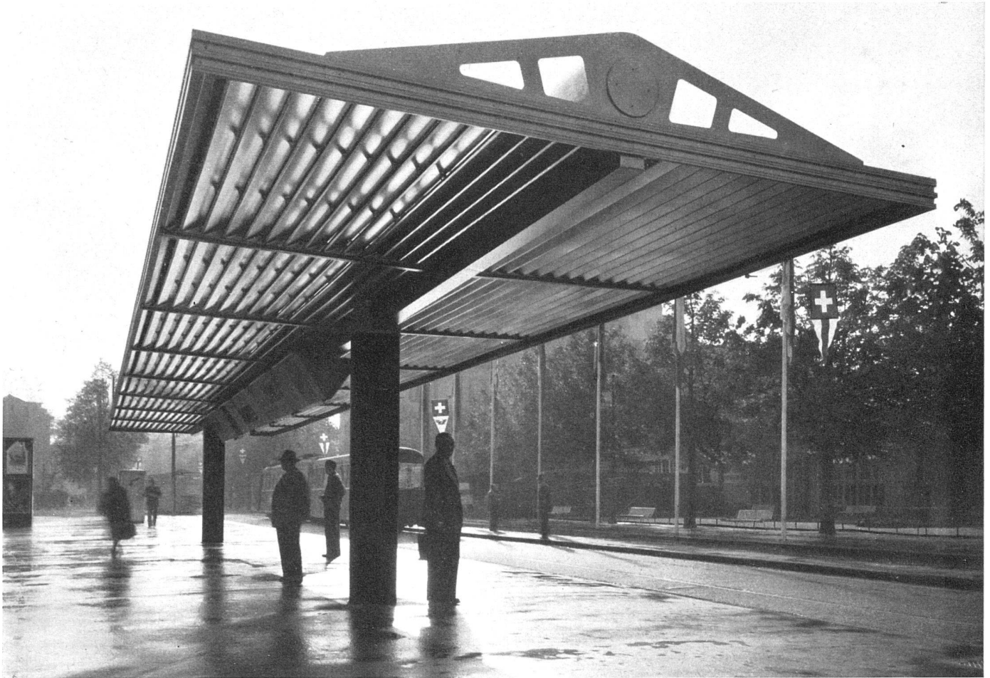
Das Perrondach vor dem Mustermessegebäude in Basel, System «Shadelite», ganz aus Aluminium, Säulen schwarz / Arrêt de tramway abrité à Bâle, système «Shadelite», exécuté entièrement en aluminium / Tramway station in Basle, system: «Shadelite», prefabricated aluminium construction Photo: Atelier Eidenbenz, Basel
