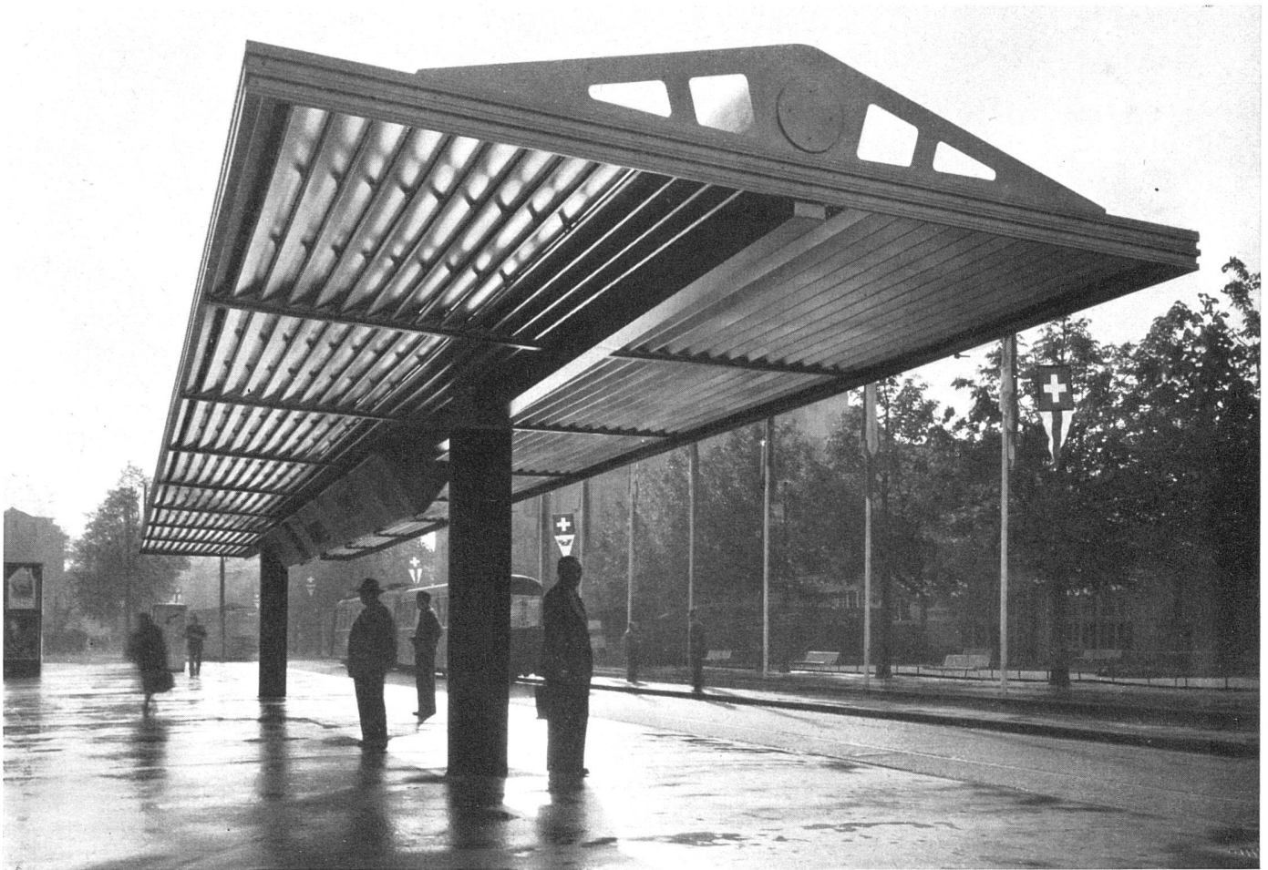
Das Perrondach vor dem Mustermessegebäude in Basel, System «Shadelite», ganz aus Aluminium, Säulen schwarz / Arrêt de tramway abrité à Bâle, système «Shadelite», exécuté entièrement en aluminium / Tramway station in Basle, system: «Shadelite», prefabricated aluminium construction Photo: Atelier Eidenbenz, Basel
