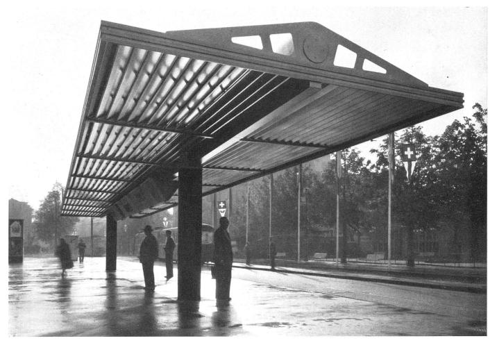
Das Perrondach vor dem Mustermessegebäude in Basel, System «Shadelite», ganz aus Aluminium, Säulen schwarz / Arrêt de tramway abrité à Bâle, système «Shadelite», exécuté entièrement en aluminium / Tramway station in Basle, system: «Shadelite», prefabricated aluminium construction
