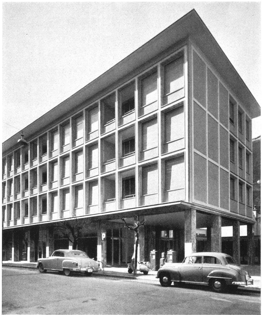
Straßenfront, von Osten gesehen / Façade sud-est / South-east elevation
