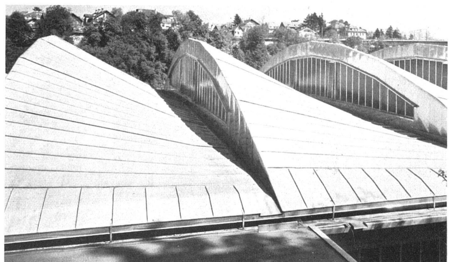
Detail der Sheds mit Aluman eingedeckt: helles Äußeres, geringe Wärmeabsorption, Lichtreflexion ins Innere / Détail des sheds / Detail of sheds covered with aluman
