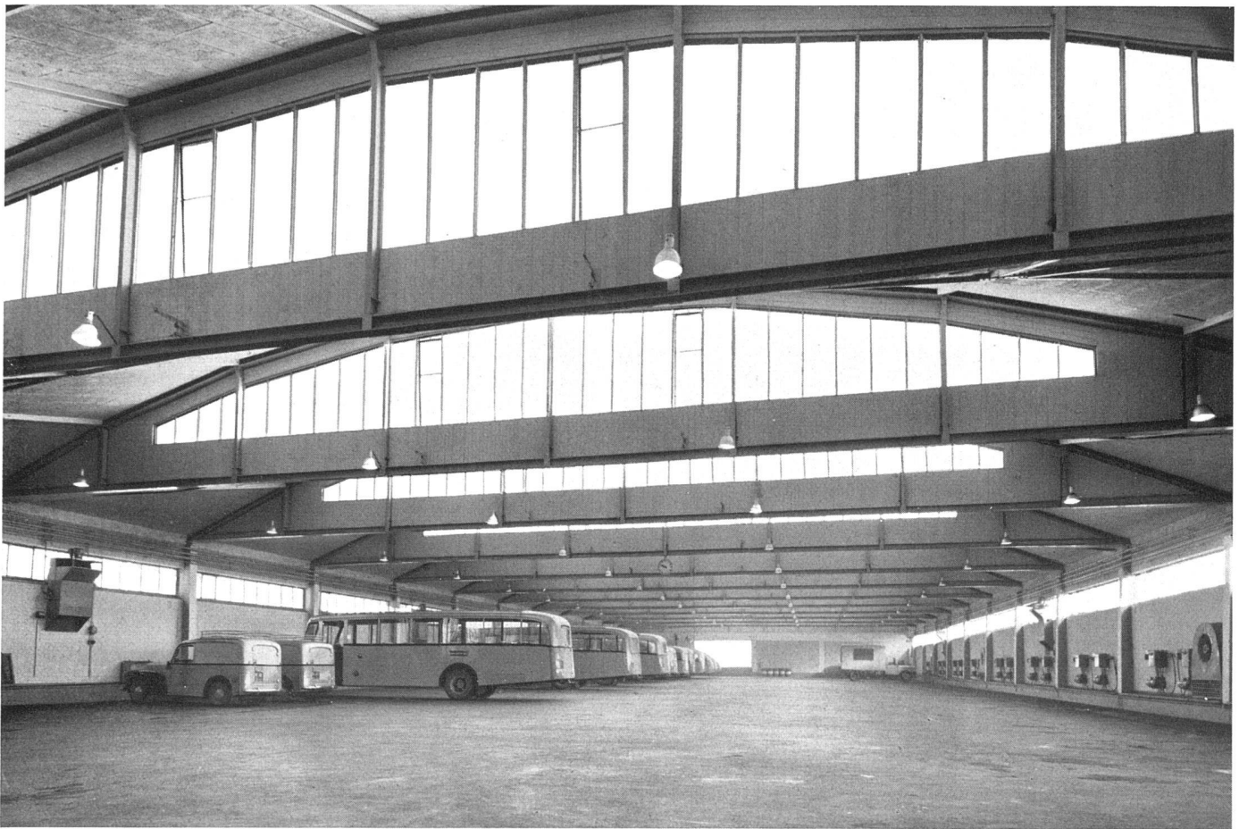
Große stützenfreie Garagehalle; Spannweite 29 m, Länge 80 m – Sheds in Eisen gegen Norden. Rechts an der Wand Ladebatterien / Le grand garage / The garages Photos: Henn SWB und Meyer, Bern
