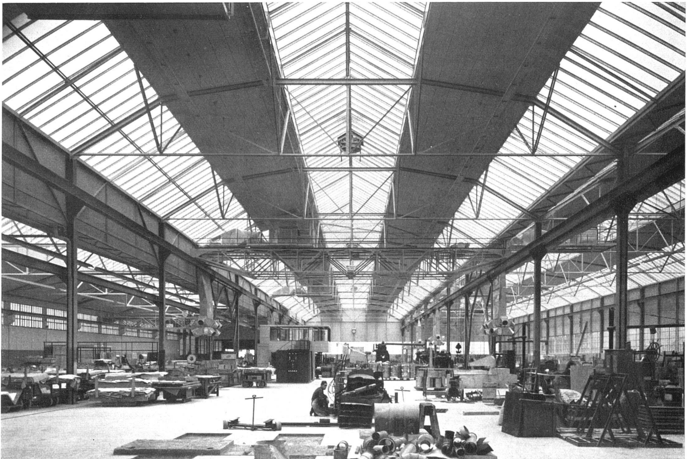
Inneres der Werkhalle | Intérieur | Interior
