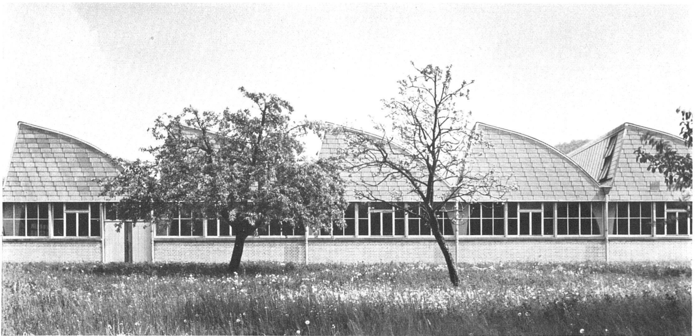
Westfassade des Shedbaus, Eindeckung mit Eternit / Ateliers à toits en shed, façade ouest / West elevation of shed building
