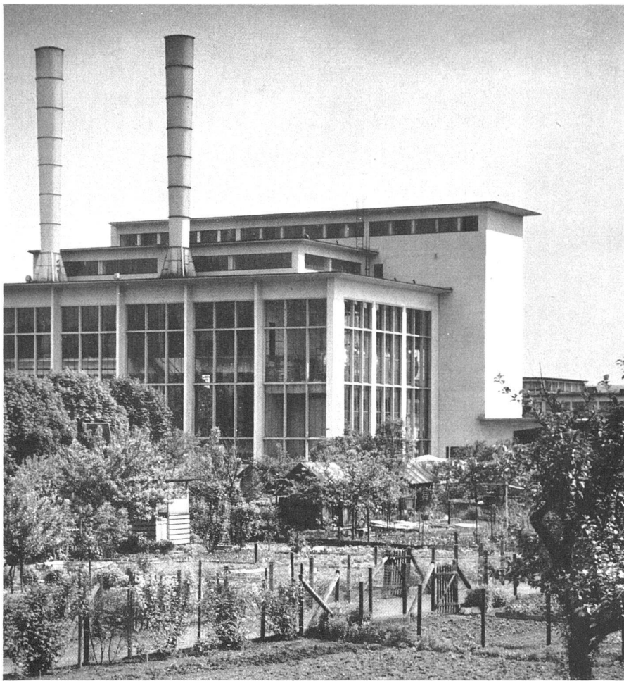
Kesselhaus; Kaminaufbauten aus Aluminium / Bâtiment de la chaufferie centrale / Heating plant building
