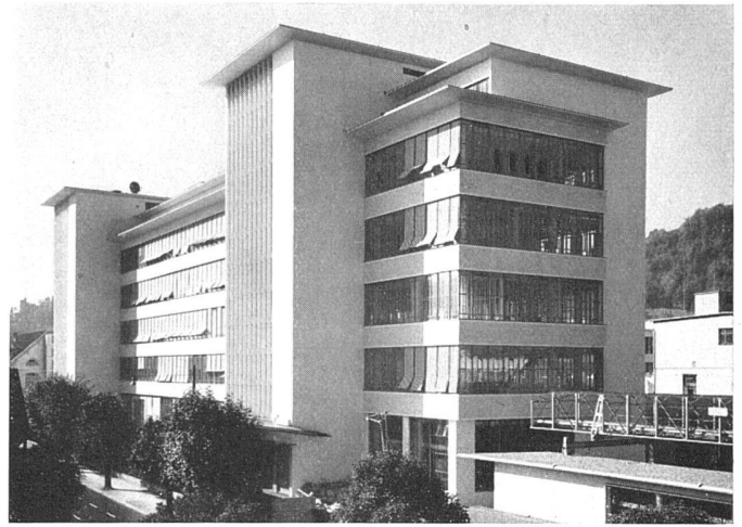
2 Fabrikationsgebäude der AG Brown, Boveri & Co., Baden. Projekt: Dr. R. Rohm, Arch. BSA/SIA, Zürich. Stat. Projekt und Ausführung: Wartmann & Co. AG, Brugg
