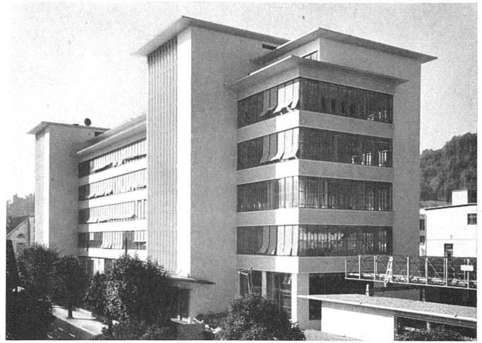
2 Fabrikationsgebäude der AG Brown, Boveri & Co., Baden. Projekt: Dr. R. Rohm, Arch. BSA/SIA, Zürich. Stat. Projekt und Ausführung: Wartmann & Co. AG, Brugg
