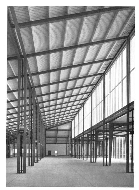
Ausstellungshalle im zweiten Obergeschoß. Shedbeleuchtung mit blendungsfreier Verglasung. Eisenkonstruktion grün, Sparrenlage mit Holzschalung weiß als Reflektor, Durotex-Bodenbelag / Salle d'exposition au second étage. Vitrage évitant l'éblouissement / Exhibition hall on second upper floor level; steel work painted green, white timber ceiling; anti-dazzle glass
