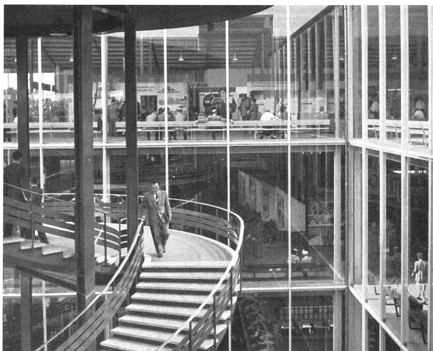
Treppendetail mit Hoffassaden; Spiegelglas-scheiben 5,5 x 2,2 m, Aluminiumsprossen / Détail des façades vitrées de la cour / Detail of the entirely glazed courtyard elevations
