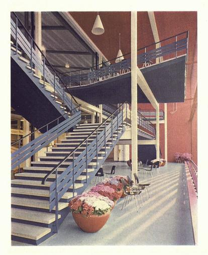
Mittelhalle über Haupteingang als Ruheraum, Treppe vom ersten zum zweiten Obergeschoß. Eisenbetonplatte auf Stahlkonstruktion, Stufen Kunststein, Boden grüner Durotexbelag / Hall du premier, au-dessus de l'entrée principale / Hall above main entrance with stairs leading to the second upper floor
