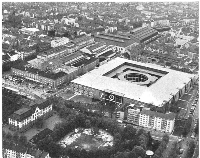
Flugbild von Osten des Messegeländes mit Neubau / Bâtiments de la Foire Suisse; vue aérienne prise de l'est / Aerial view of the Swiss Fair buildings, from the east Comet-Photo AG, Zürich
