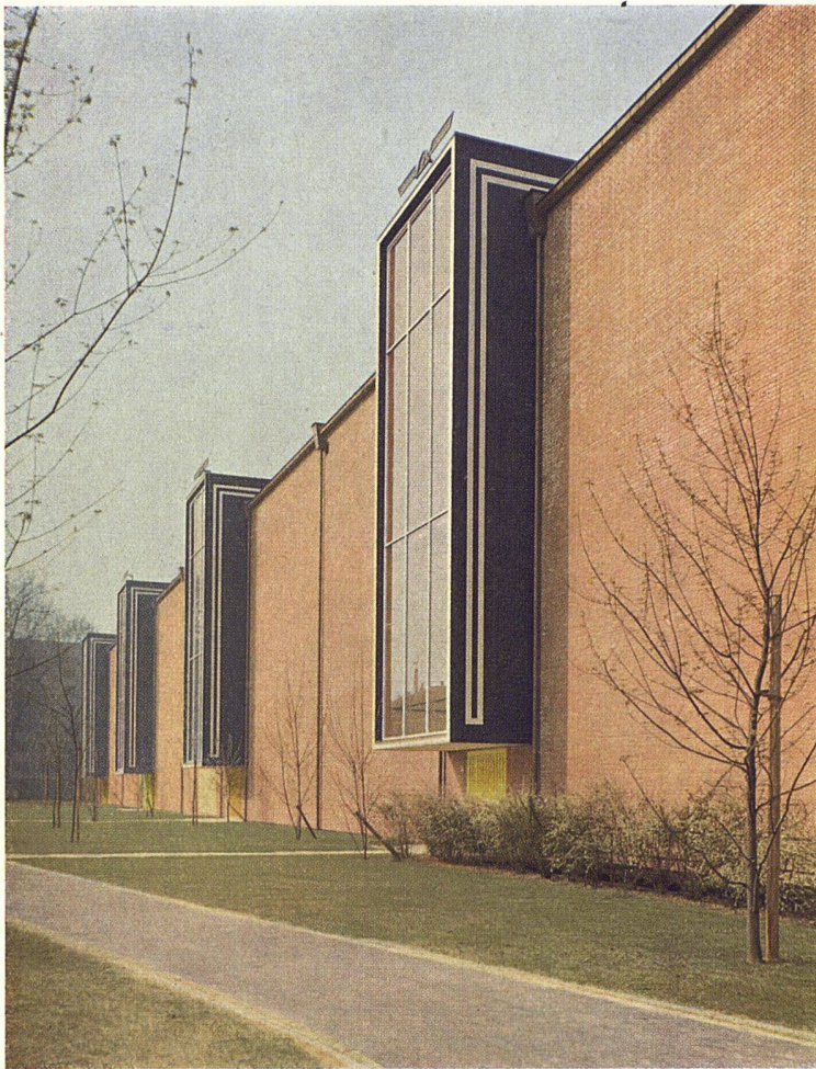
Seitenfassade an der Mattenstrasse mit Grünfläche / Façade latérale et cages d'escaliers / Side elevation with staircases
