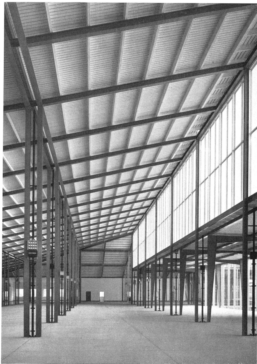
Ausstellungshalle im zweiten Obergeschoß. Shed- beleuchtung mit blendungsfreier Verglasung. Eisenkonstruktion grün, Sparrenlage mit Holz- schalung weiß als Reflektor, Durotex-Boden- belag / Salle d'exposition au second étage. Vi- trage évitant l'éblouissement / Exhibition hall on second upper floor level; steel work painted green, white timber ceiling; anti-dazzle glass
