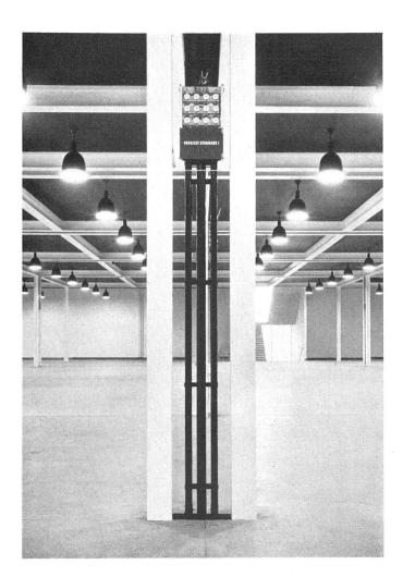
Zwillingssäule mit Installationen für Ablauf, Wasser, Gas, Licht- und Kraftstrom, Telephon | Double colonne combinée avec installations pour eau, canalisation, gaz, électricité (lumière et force), téléphone | Twin columns combined with the necessary installations for water, canalisation, gas, electricity, telephone
