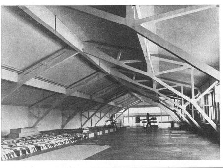
Raumsparende und leichte Dachstuhlkonstruktion in einem Industriebau
