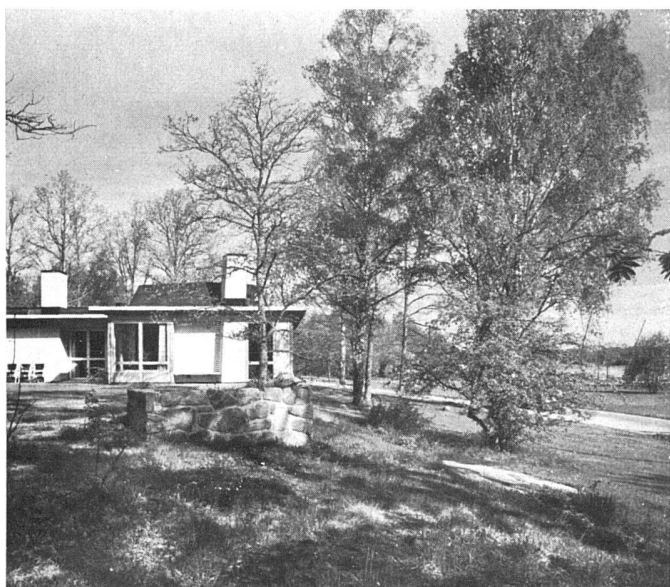
Von Südosten mit Blick auf Meeresbucht | Vue prise du sud-est | From the south-east
