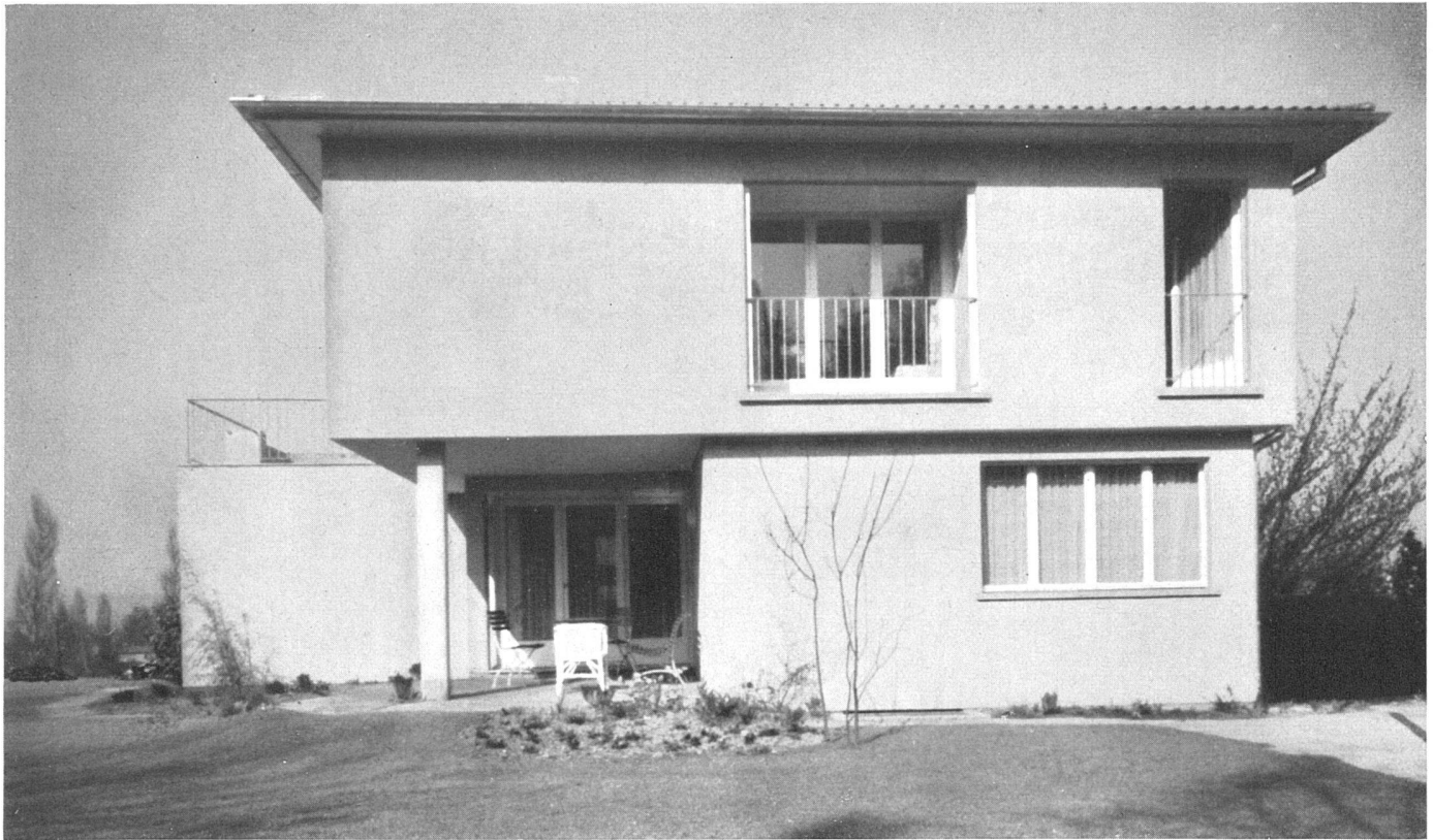
Ansicht von Südwesten mit Gartenhalle | Vue prise du sud-ouest | From the south-west
