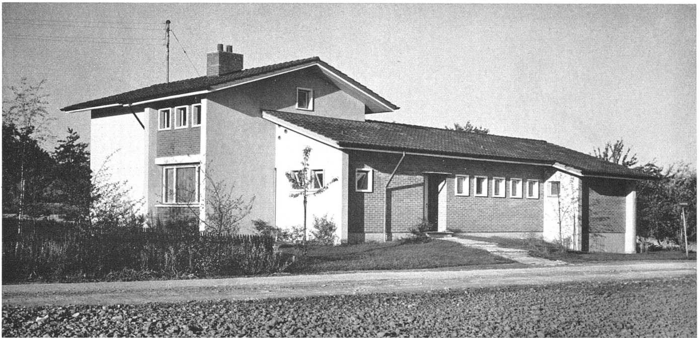
Gesamtansicht von Nordosten mit Eingang | Façade de l'entrée, vue prise du nord-est | Entrance elevation from the north-east
