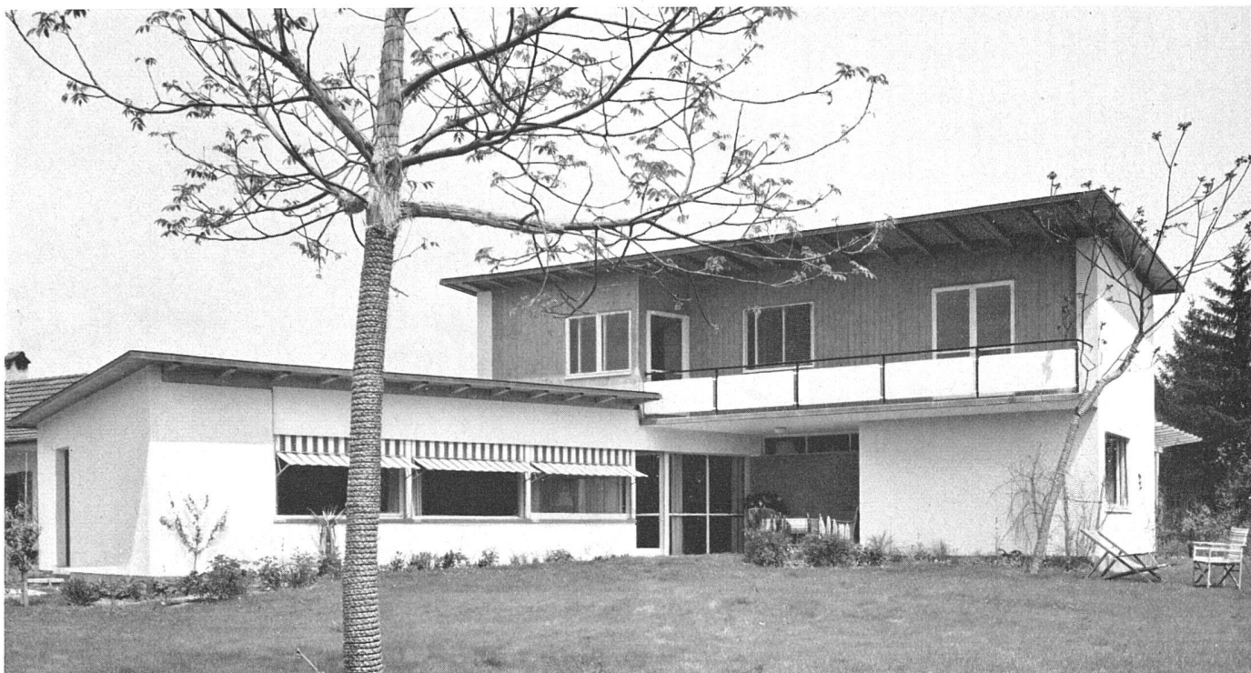
Gesamtansicht von Süden | Vue prise du sud | General view from the south
