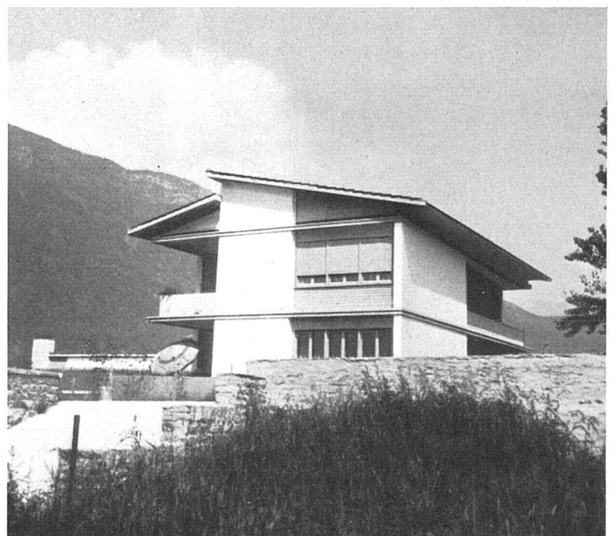
Haus B von Süden | Maison B; vue prise du sud | House B, from the south
