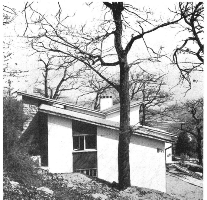
Südwestliche Stirnseite | Façade sud-ouest | South-west elevation
