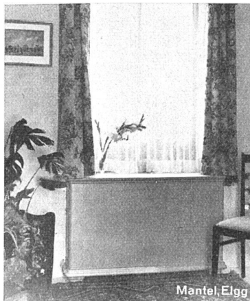
Unter der Fensterbrüstung eingebauter Ofen. Je nach Zimmerlage und Größe genügen 1—2 solcher Wärmequellen.
