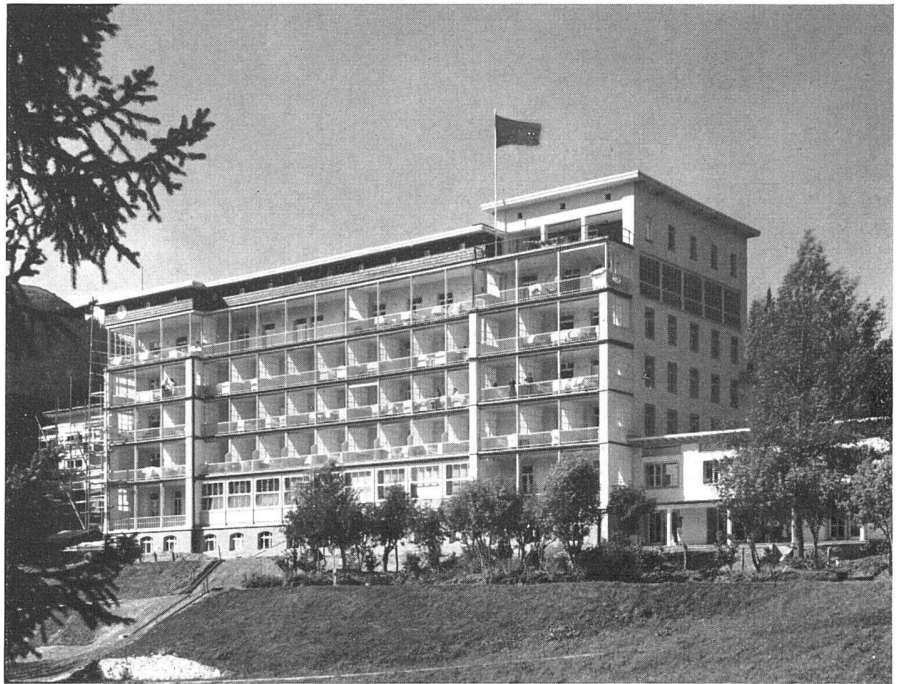
Das umgebaute Sanatorium | Le sanatorium après la transformation | The remodelled sanatorium
