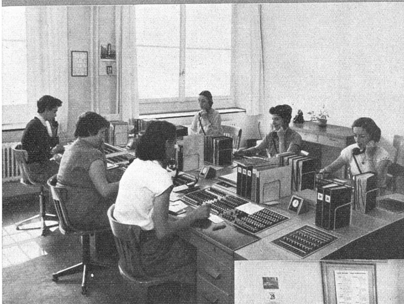
Telephon-Anlage bei der Börsen/Devisen-Abteilung. Diese Einrichtung erlaubt die Herstellung direkter Gesprächsverbindungen zu anderen Abteilungen, durch einfachen Tastendruck. — Jederzeitiges Eintreten auf jede beliebige Börsen- und Devisenleitung von allen Stationen aus. — Automatisches Halten der Leitungen — Eindeutige Signalisierung der Verbindungen durch Signallampen — Trennung der Leitungen durch Tastendruck.
