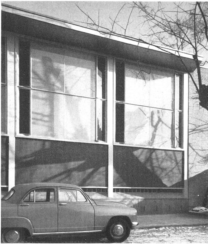
Fassadenausschnitt; Verkleidung, Spenglerarbeit und Fenster aus Aluminium | Détail de façade montrant l'emploi multiple de l'aluminium | Elevation detail showing the manifold use of aluminium
