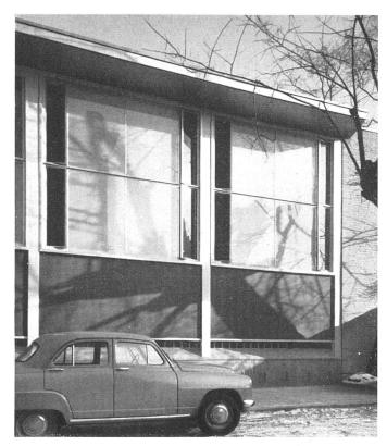
Fassadenausschnitt; Verkleidung, Spenglerarbeit und Fenster aus Aluminium | Détail de façade montrant l'emploie multiple de l'aluminium | Elevation detail showing the manifold use of aluminium
