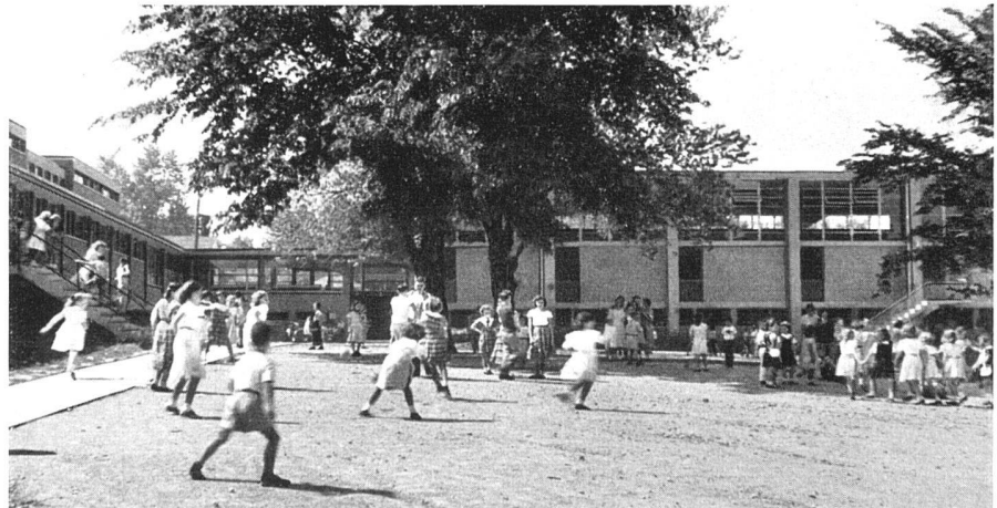
Der Pausenhof, im Hintergrund der Versammlungsbau / La cour de récréation; à l'arrière-plan, la salle de réunion (église) / Playing area, in the background, the assembly hall (church)
