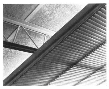
Detail der Decke; Oberlicht geschützt durch Metallamellen | Détail du plafond | Detail of ceiling, top-lighting controlled by louvres
