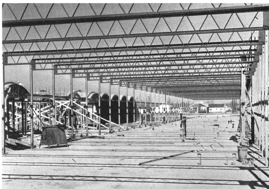
Das leichte Konstruktions-Skelett | L'école en état de construction, ossa- ture métallique légère | The light steel skeleton
