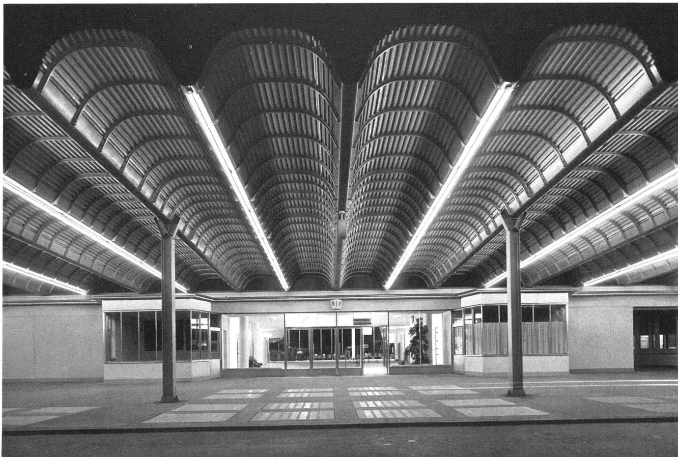
Eingang für abfliegende Passagiere, Konstruktion in Aluminium / L'entrée pour le départ des passagers / Departing passengers' entrance
