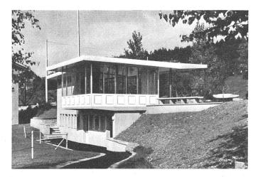
Stadtspital Waid, Zürich / Buswartehalle mit Kiosk und Telephonkabine Ausführung in Eisenkonstruktion mit Anticorodalverkleidungen
