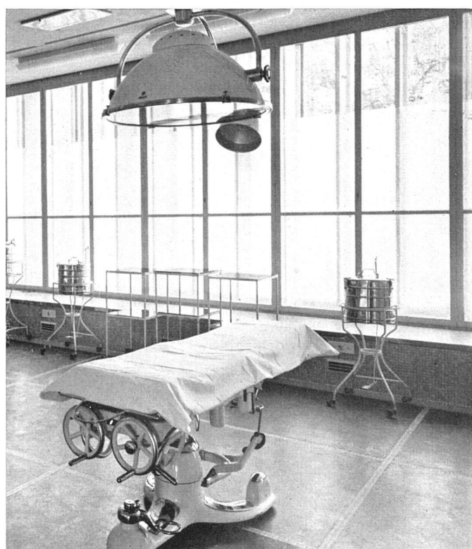
Fensterwand eines Operationssaales, zwischen den beiden Glasflächen Metall-Lamellen zur Abblendung und Verdunkelung | Salle d'opération. Entre les deux parois de verre, écran mobile à lamelles métalliques pour l'obscurcissement de la salle | Operation room, double-glazed window with adjustable metal blinds for lighting control and darkening 31
