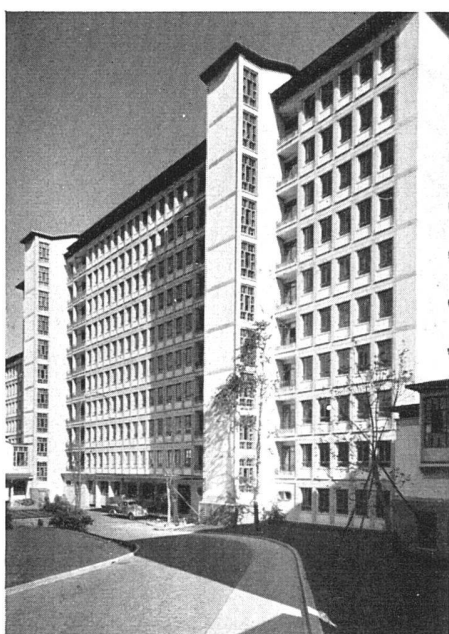
Nordwestfront mit Nebenräumen des Bettenhauses «West». Zufahrt zur Warenannahme / Bâtiment d'hospitalisation «Ouest», façade nord-ouest (locaux de service) / North-west elevation of bedroom wing «West» (service rooms) 39
