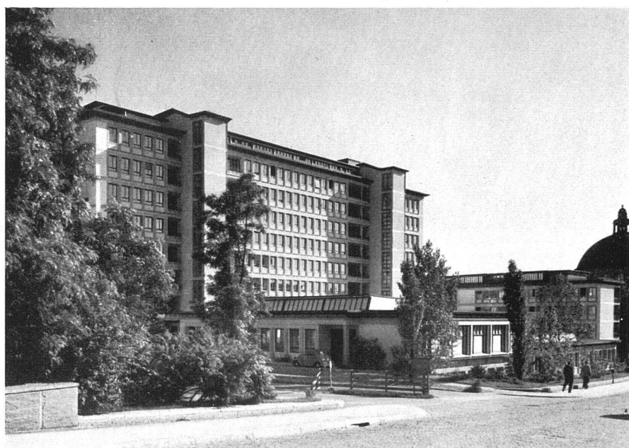
Bettenhaus «West» von Norden gesehen, im Vordergrund die chirurgische Poliklinik. Die in der ersten Bauetappe (Polikliniktrakt) entwickelten Elemente, wie Treppenhäuser, Fensterachsen (1.60 m), wiederholen sich in der ganzen Spitalanlage / L'aile d'hospitalisation «Ouest», vue prise du nord; au premier plan, la polyclinique chirurgicale / The bedroom wing «West» from the north, in the foreground, the surgical polyclinic 40
