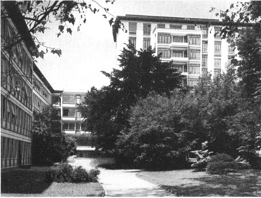
Polikliniktrakt und Bettenhaus «West» mit Verbindungsbau von Südosten / Le bâtiment des polycliniques (à g.), et l'aile d'hospitalisation «Ouest» / The polyclinics' wing (at l.), the connecting building and the bedroom wing «West», from the south-east 9
