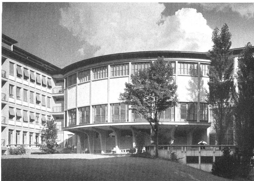
Der große Hörsaal vom Hof aus gesehen. Zurückspringendes Sockelgeschoß mit Sitznischen / Le grand amphithéâtre vu du dehors; en bas, niches garnies de bancs / Exterior of the large auditorium, covered sitting area at garden level 38
