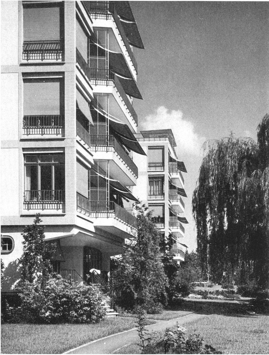
Bettenhaus «Ost I», Erker und Bal- kone der Achterzimmer | L'aile d'hos- pitalisation «Est I»; les corps en saillie abritent les chambres à 8 lits | Bed- room wing «East I», detail of corner windows and balconies of the rooms with 8 beds
