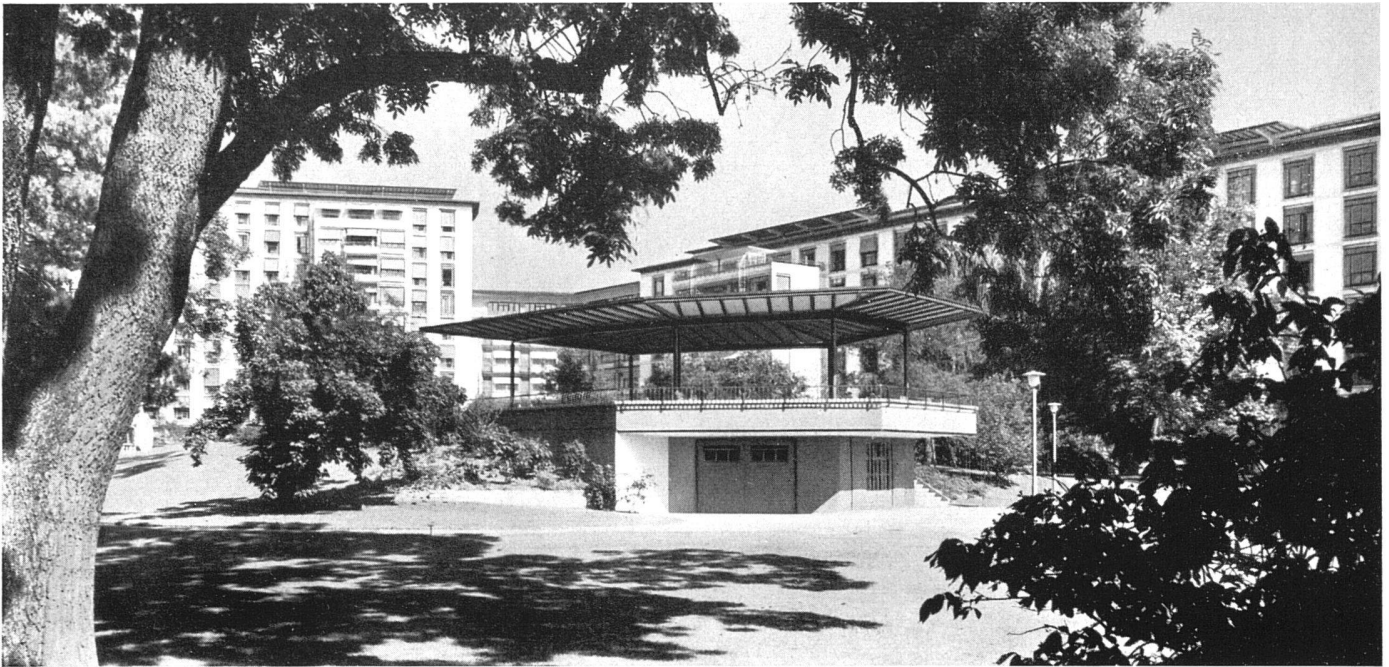
Ausschnitt aus dem Spitalpark mit Gartenpavillon, darunter Eingang zu dem beibehaltenen und hügelartig übererdeten Keller des alten Spitals / Partie du parc, au premier plan, le pavillon de récréation / Part of the park, in the foreground, the garden pavilion with the entrance to a cellar left over from the old hospital
