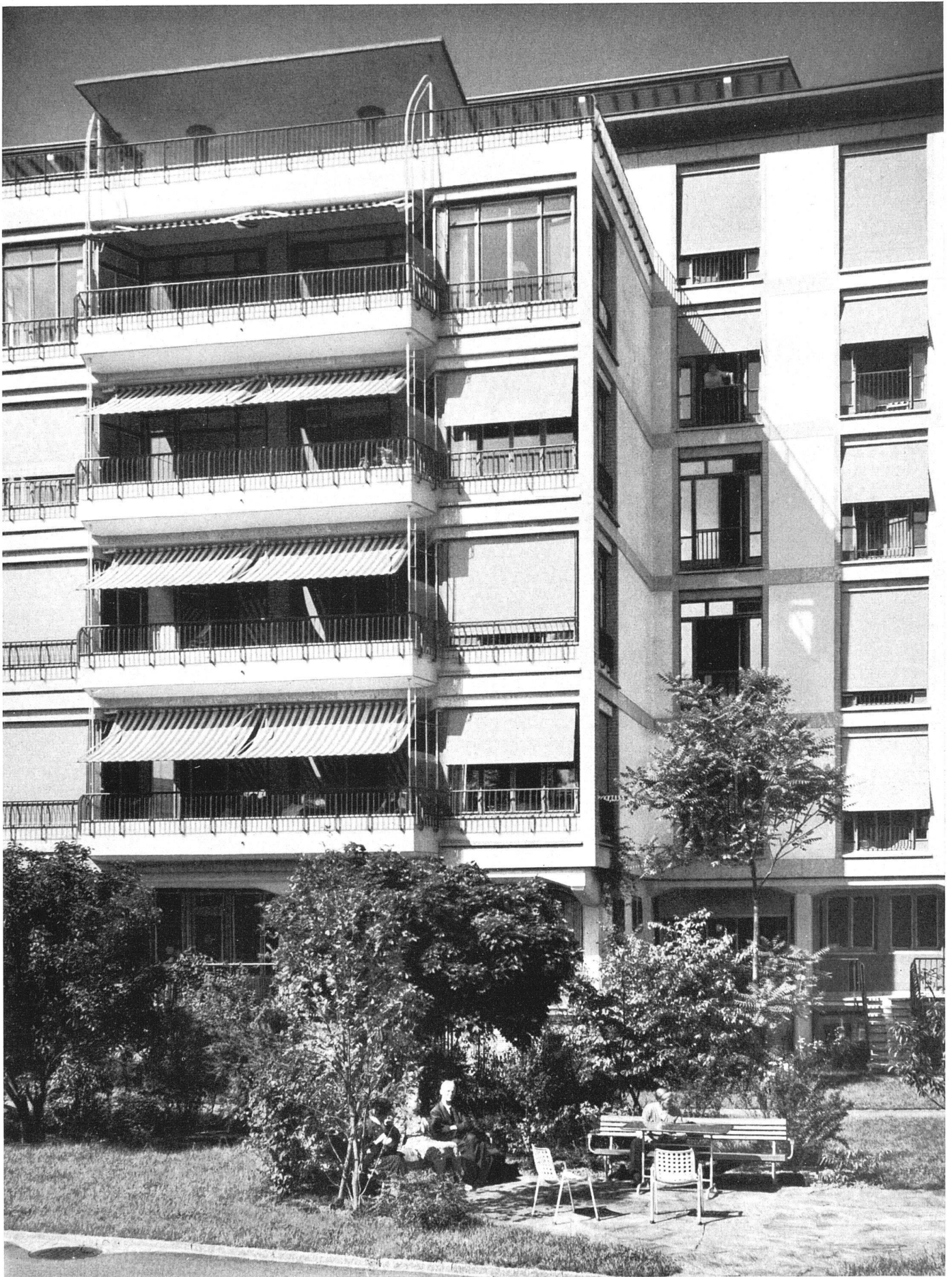
Ausschnitt Gartenfront des Bettenhauses «Ost» | Partie de l'aile d'hospitalisation «Est» | Part of garden elevation of bedroom wing «East»
