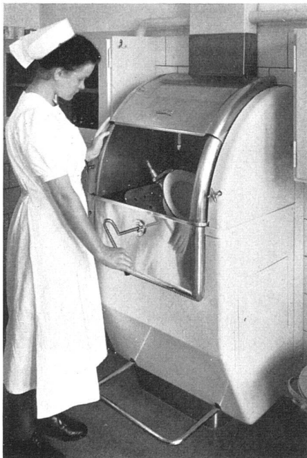
Reinigungsapparat Modell AKZ (im Ausgußraum) für Steckbecken, Urinflaschen, Schalen usw. / Appareil servant au nettoyage des pots, bouteilles, vases, etc. / Washing machine for pots, bottles, bowls, etc.
