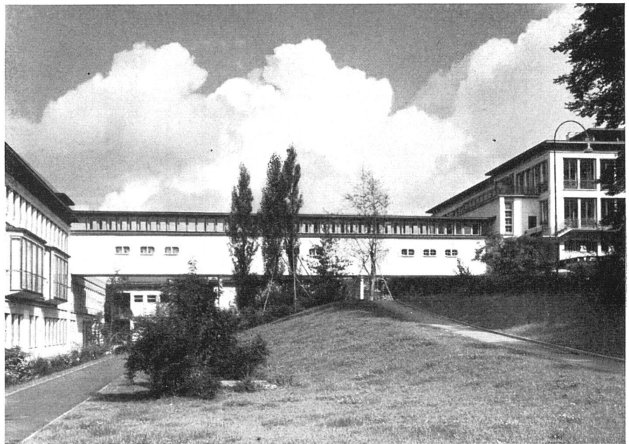
Zweigeschossige Verbindungsbrücke zwischen Hauptbauten und Küchentrakt (mit Personal-speisesälen), links Operationsflügel / Passerelle à deux étages reliant la cuisine aux bâtiments principaux / Double-deck bridge connecting the kitchen wing with the main buildings; at l., the operation wing 42
