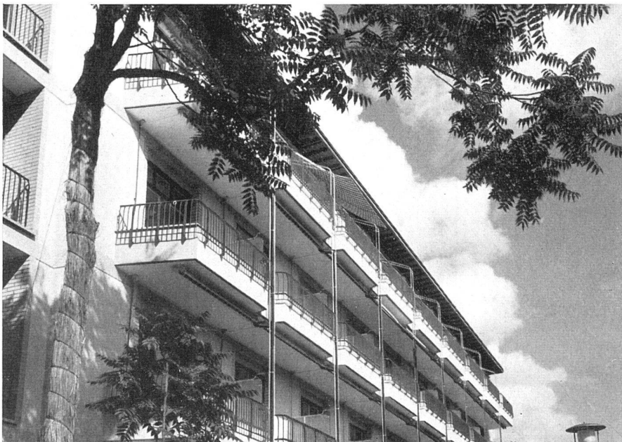
Detail der Balkone mit durchgehenden Gerüsten für Kletterpflanzen / Détail des balcons / Detail of balconies 18
