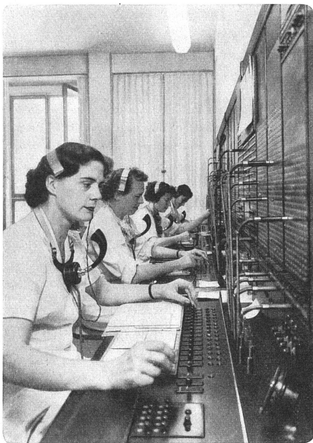
Telephon-Vermittlungseinrichtung im Kantonsspital Zürich für 50 Amtsleitungen und 1200 Teilnehmeranschlüsse, mit Nachtpikettstellen, Direktionsanlagen und Feuersalarm-Ausrüstung
