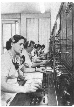
Telephon-Vermittlungseinrichtung im Kantonsspital Zürich für 50 Amtsleitungen und 1200 Teilnehmeranschlüsse, mit Nachtpikettstellen, Direktionsanlagen und Feueralarm-Ausrüstung
