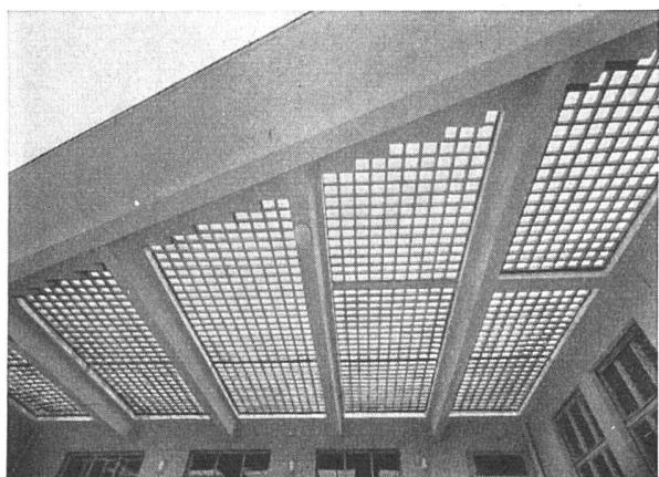
**GLAS-BETONBAU** für Wände, begeh- und befahrbarre Oberlichter, garantiert wasserdicht
