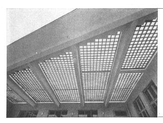
GLAS-BETONBAU für Wände, begeh- und befahrbare Oberlichter, garantiert wasserdicht
