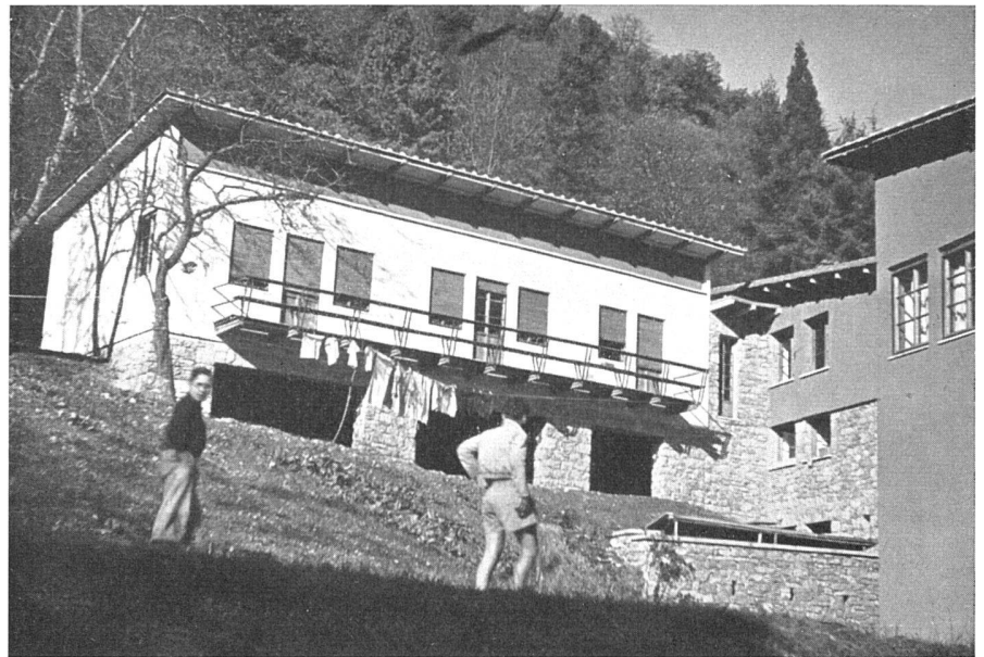
Westlicher Schlafpavillon mit Front gegen Südosten | Façade sud-est du dortoir ouest | Western dormitory facing South-East
