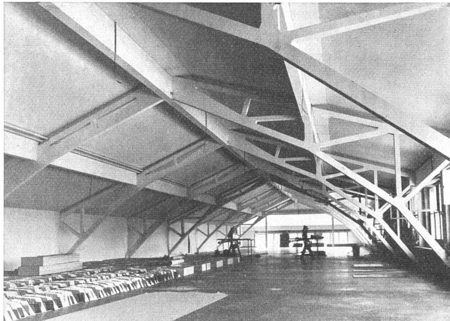
Raumsparende und leichte Dachstuhlkonstruktion in einem Industriebau
